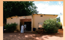
既存の保健センター(新しい施設を建設中)
