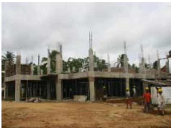
3. ラトゥガマ警察署建設状況（その1） （2005年11月4日撮影）
