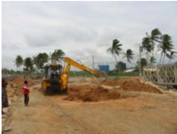
2005. 11.04 Akurala Bridge 建設状況 ( 1 )
