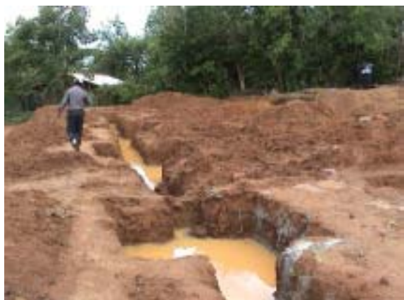
2005. 10.27 Kudawella 学校 建設状況 ( 1 )
