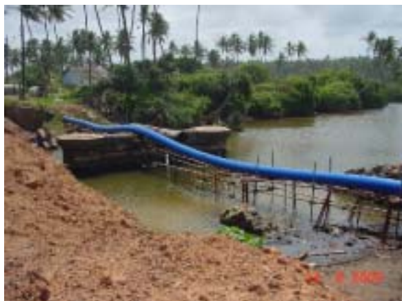
2005.06.14 水管橋 仮管設置状況(1)
