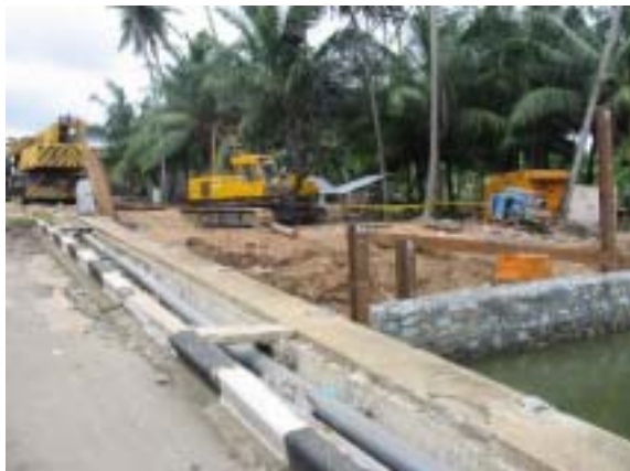
2005. 11.04 Magalle Bridge 建設状況 ( 1 )
