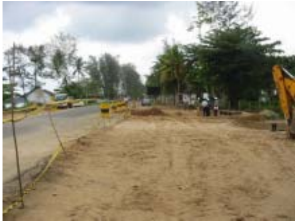
2005. 11.04 Weligama culvert 建設状況 ( 1 )
