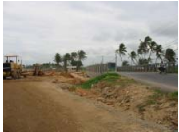
2005. 11.04 Akurala Bridge 建設状況 ( 2 )
