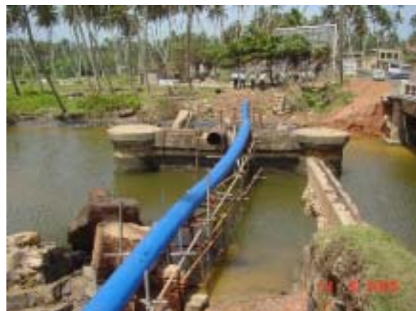
2005.06.14 水管橋 仮管設置状況(2)
