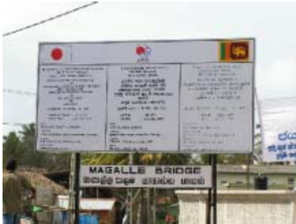
2005.08.14 南部橋梁 看板 (Magalle Bridge)
