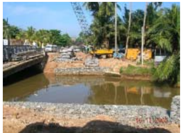
2005. 11.04 Magalle Bridge 建設状況 ( 2 )
