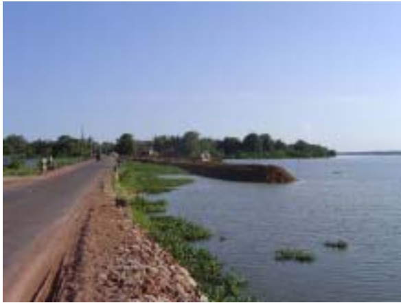
2005.11.23 東部コースウェイ建設状況(1)
