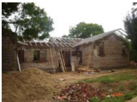
10. キリンダ警察署の建設状況(その2) (2005年11月4日撮影)
