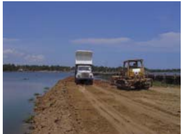
2005. 11.23 東部コースウェイ建設状況(4)
