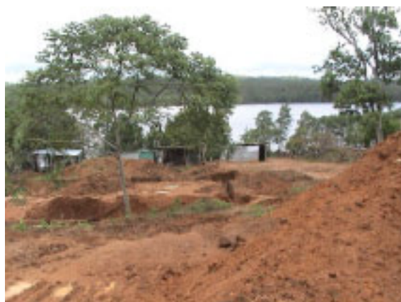
2005. 10.27 Kudawella 学校 建設状況 ( 2 )
