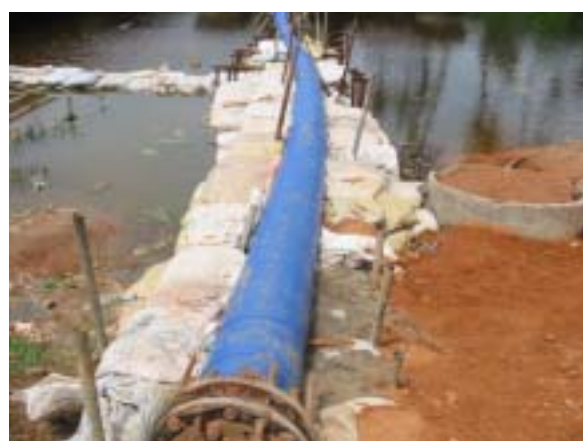
2005.11.04 水管橋 仮管補修済み(2)
