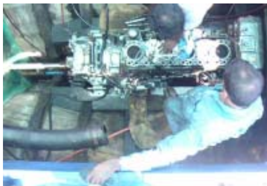
船倉に据え付けられているエンジンを オーバーホールしているエンジニア
