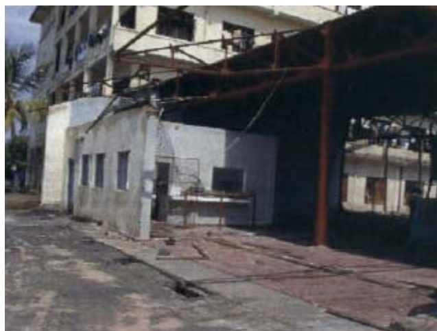
ゴール漁港 冷凍冷蔵施設
