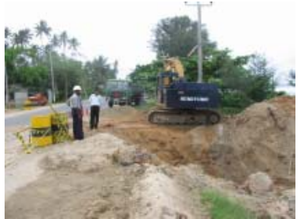
2005. 11.04 Weligama culvert 建設状況 ( 2 )
