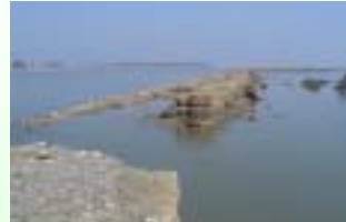
津波で寸断された護岸(アチェ)
