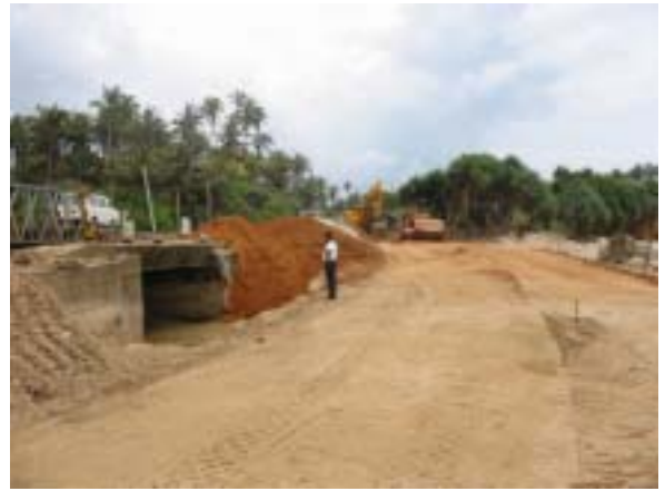
2005. 11.04 Goiyapana Bridge 建設状況 ( 2 )
