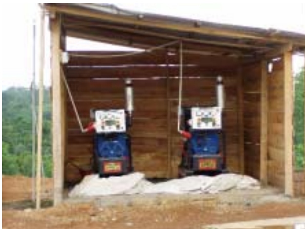
2005.10.10 発電機 設置状況（1）
