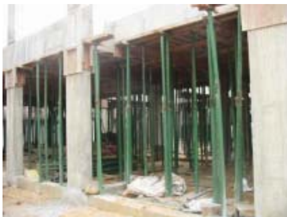
4. ラトゥガマ警察署建設状況（その2） （2005年11月4日撮影）
