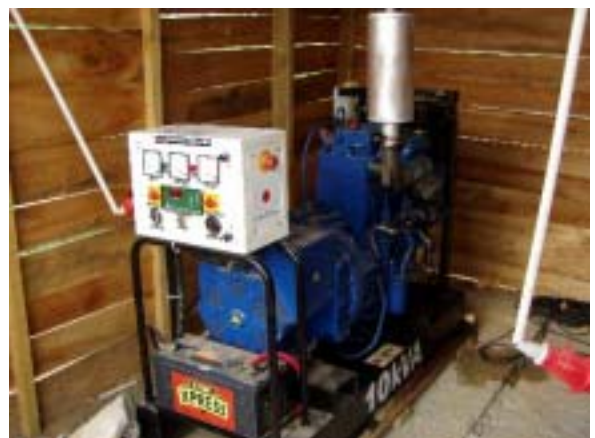
2005.10.10 発電機 設置状況（2）
