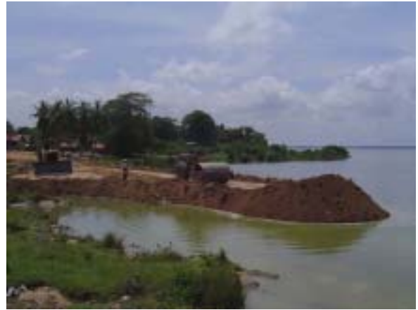
2005. 11.23 東部コースウェイ建設状況(2)
