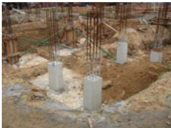
8. ディクウェラ警察署の建設状況(その2) (2005年11月4日撮影)
