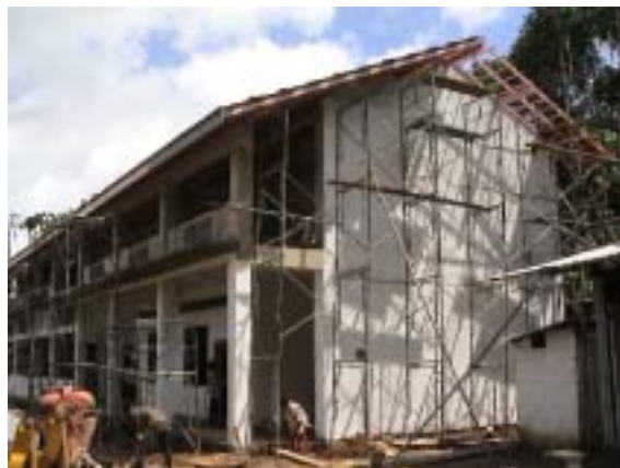
2005. 11.04 Deepamkara 学校 建設状況
