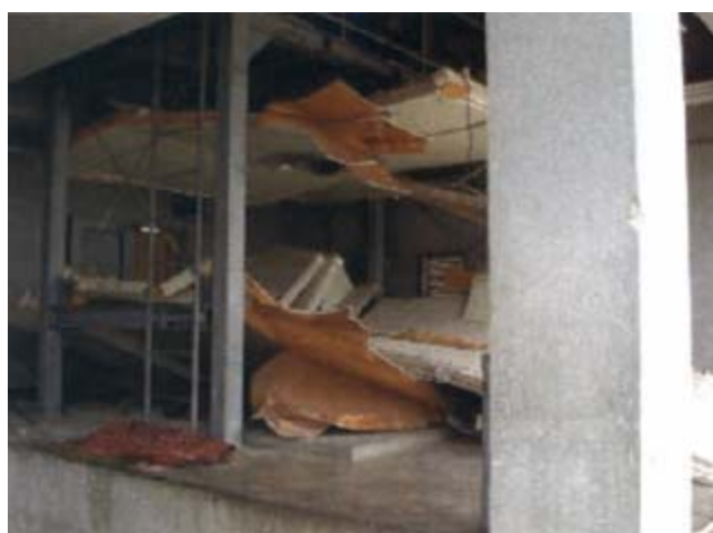
タンガラ漁港 冷凍施設
