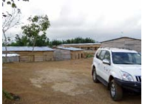
2005.11.04 発電機設置 被災キャンプ
