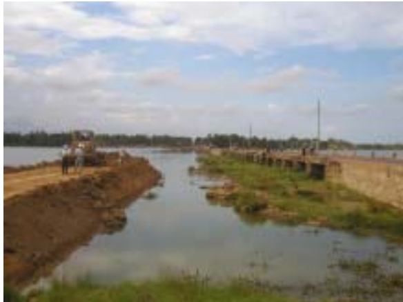
2005.11.23 東部コースウェイ建設状況(3)
