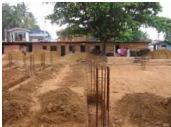
7. ディクウェラ警察署の建設状況(その1) (2005年11月4日撮影)
