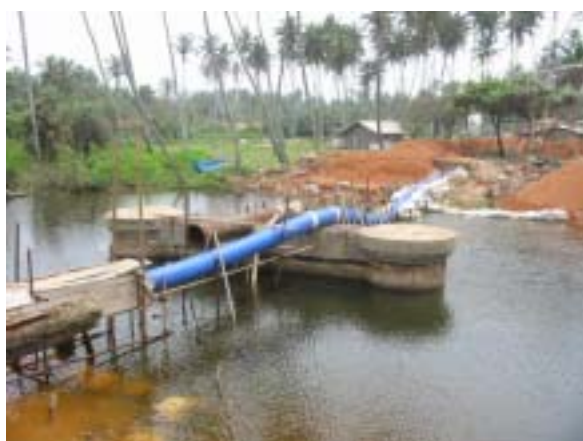
2005.11.04 水管橋 仮管補修済み(1)
