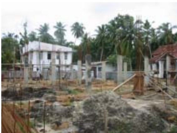
6. 建設工事が着実に進捗していることが確認されている。 （コスゴダ警察署：2005年11月4日撮影）
