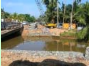
南部橋梁建設状況
