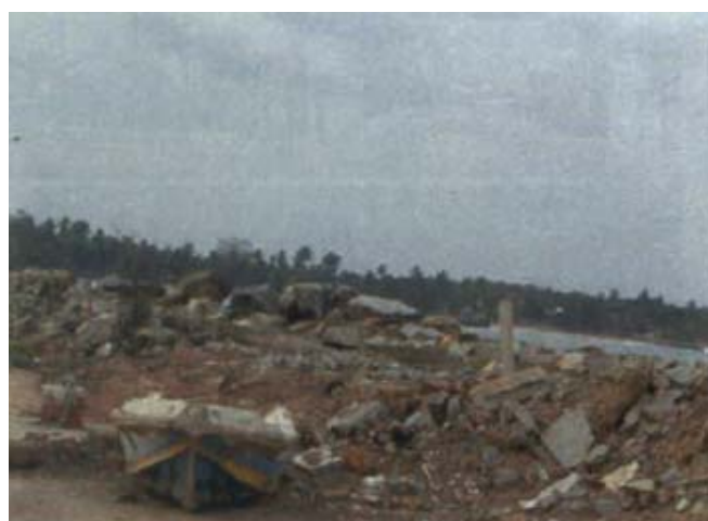
タンガラ漁港 防波突堤
