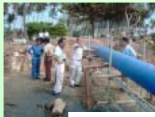
被災現場調査
