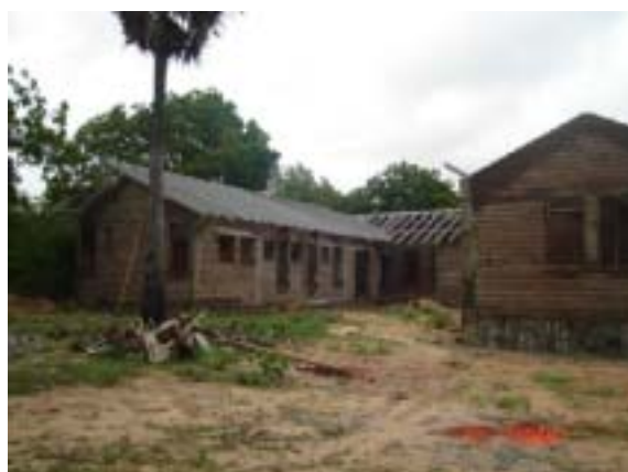
9. キリンダ警察署の建設状況(その1) (2005年11月4日撮影)
