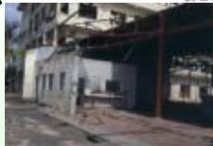
被災した冷凍施設(スリランカ)
