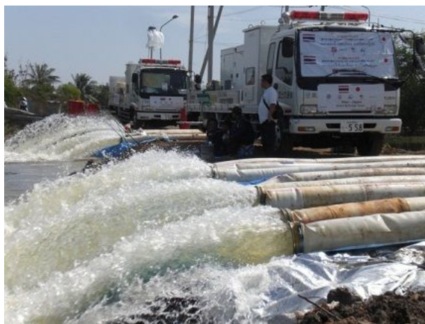
【写真】タイ洪水災害における排水ポンプの活動現場
