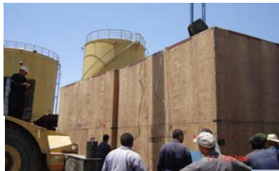
モスル発電所復興事業 (イラク)
