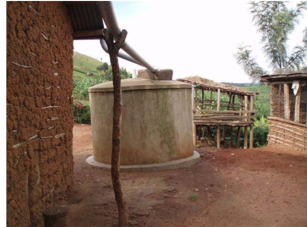
雨水貯水タンク外観
